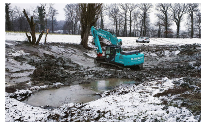
Baggerarbeiten Liberatorweiher (Foto: Clemens Gnädinger)
